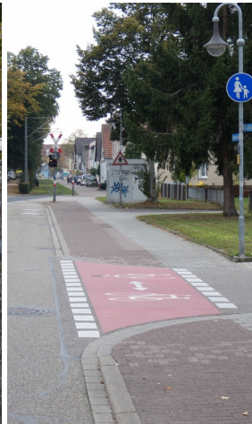
Links: Beginn Tempo-30-Zone, ab hier keine Freigabe mehr (Zusatzschild Freigabe der Gegenrichtung von hinten zu sehen); Mitte: Alter Radweg noch erkennbar, aber keine Freigabe, dafür mit überflüssiger Furt; rechts: Nach Umbau alter Radweg nicht mehr erkennbar und ohne Furt. Auf den Fahrbahnen: Pliktogrammspur
